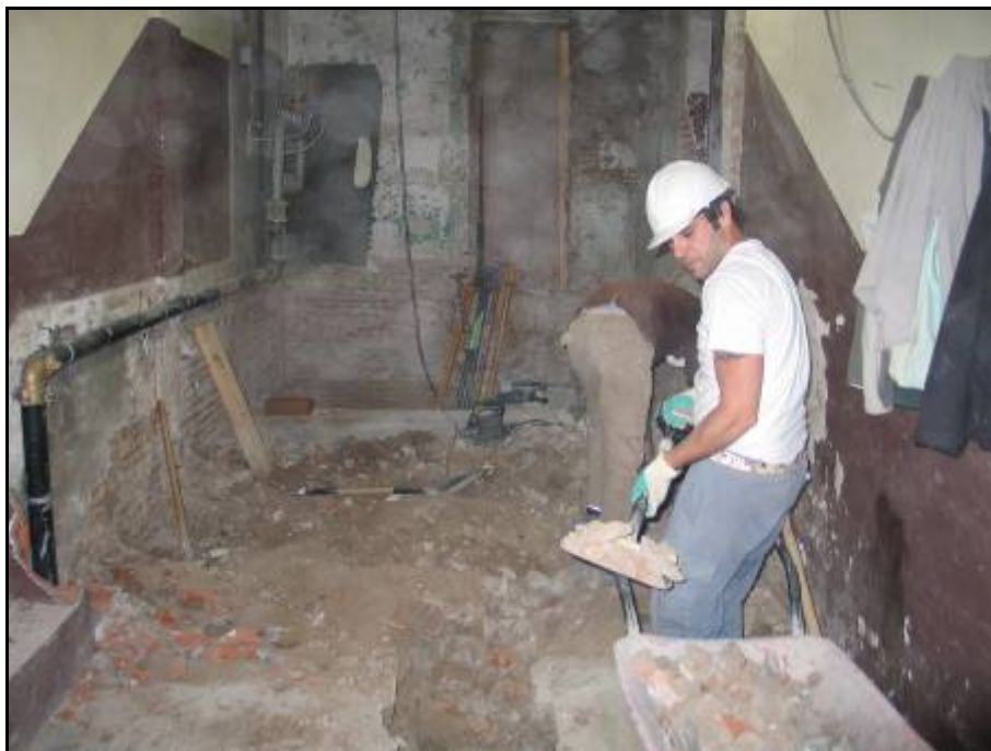
Aixecament del paviment.
