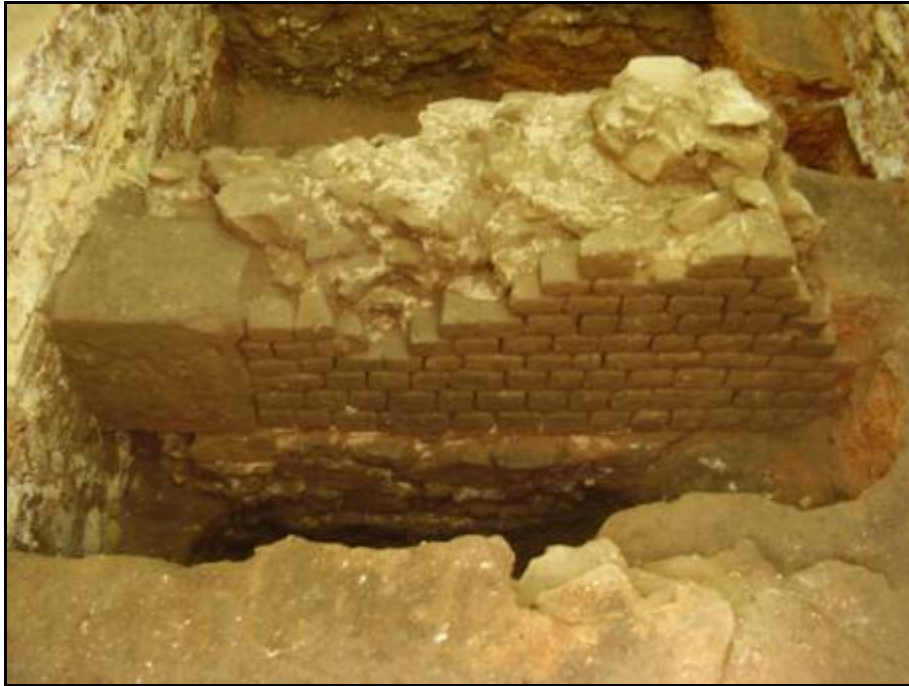
Vista de la cara externa del mur romà UE 2004. Opus vittatum .
